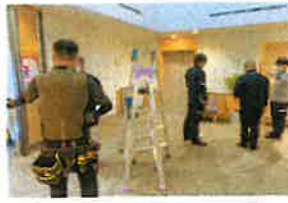
ICT導入工事着工
